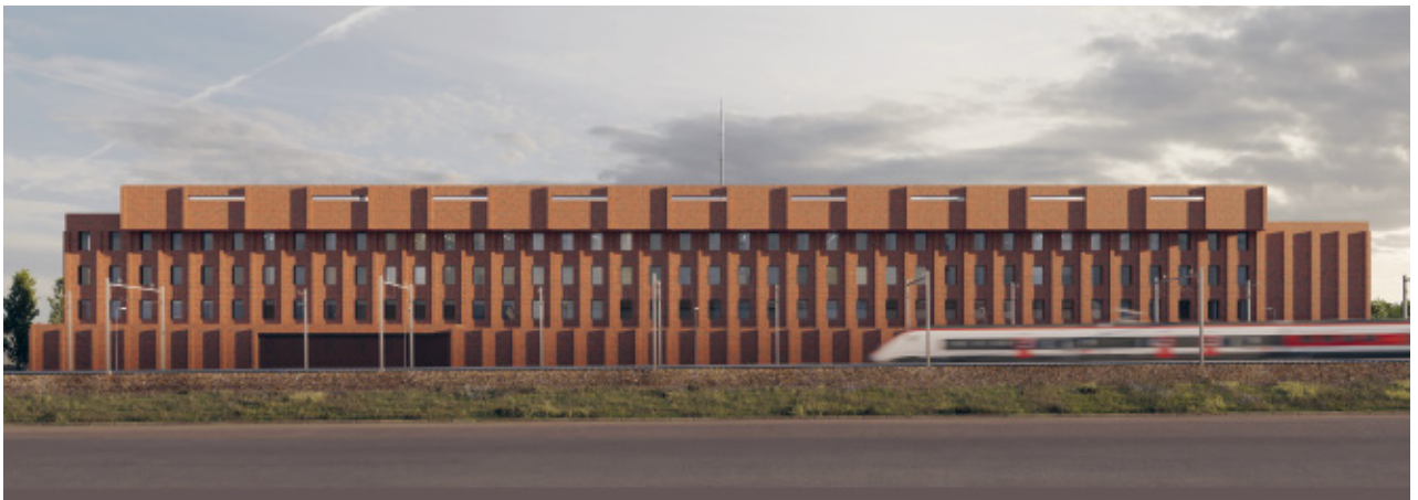
Das geplante Kantonale Gefängnis und Polizeihauptquartier der Kantonspolizei Thurgau bereichern das Ortsbild in Frauenfeld.
