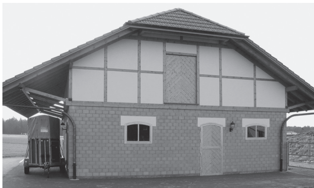
Halle industrielle à Maçonnerie apparente I+L lisse + roulée.
