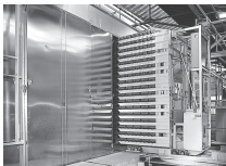
Les charriots de pose reprennent les masses moulées et les transportent vers les chambres sèches.
