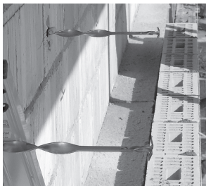
Maçonnerie à double paroi en briques de terre cuite
