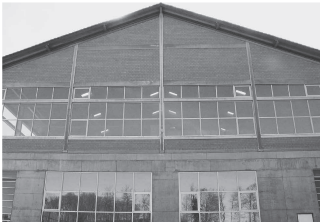
Halle industrielle à Rapperswil-Bern, Maçonnerie apparente I+L lisse + roulé.
