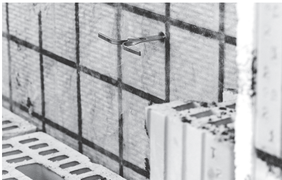
Ancrage à spirale ZZ, qui a été fixé à la paroi arrière au moyen d'un manchon perforé rempli de mortier bicomposant.
